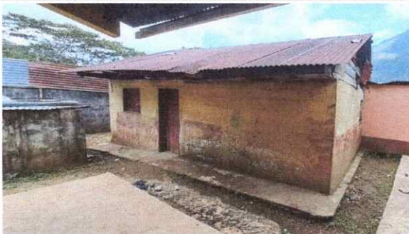
Foto 5: Sustitucion de laminas y estructura de soporte.
